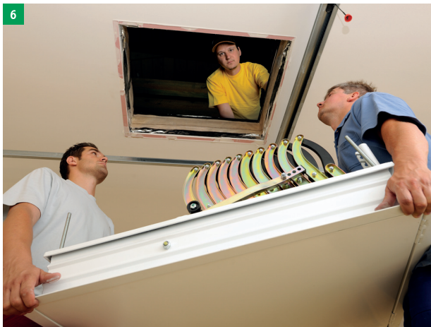
dvě osoby vyzvednou schody do stavebního otvoru
