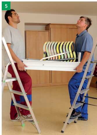
kontrola dodaného typu a rozměru stahovacích schodů
