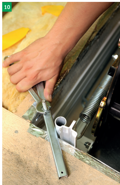
10 řádné utažení 4 ks kotevních šroubů
