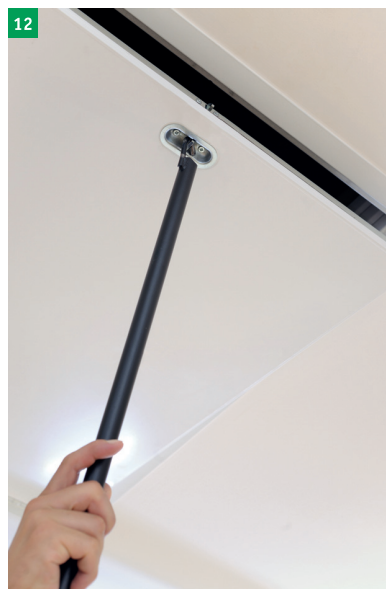
12 nasazení stahovací tyče a otevření víka
