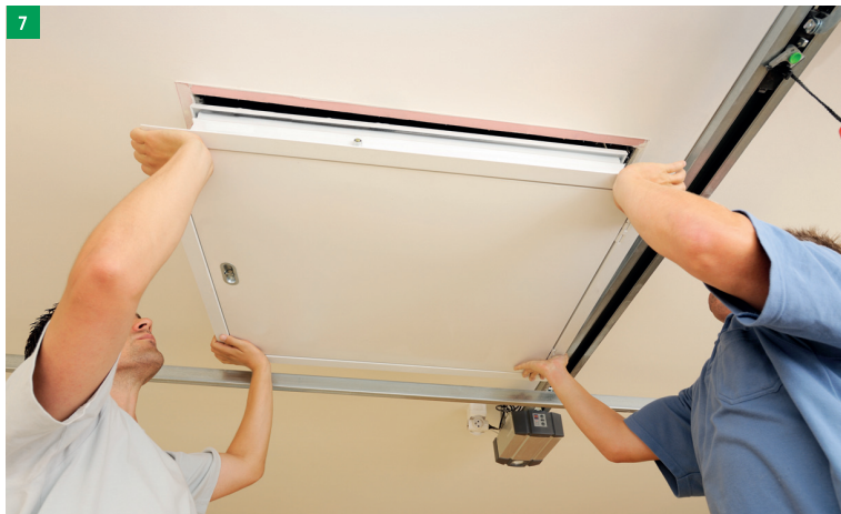
vsazení schodů do stavebního otvoru
