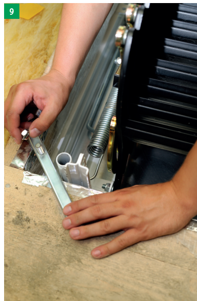
9 třetí osoba, která je již v půdním prostoru pomocí 4 ks nosníků upevní rám
