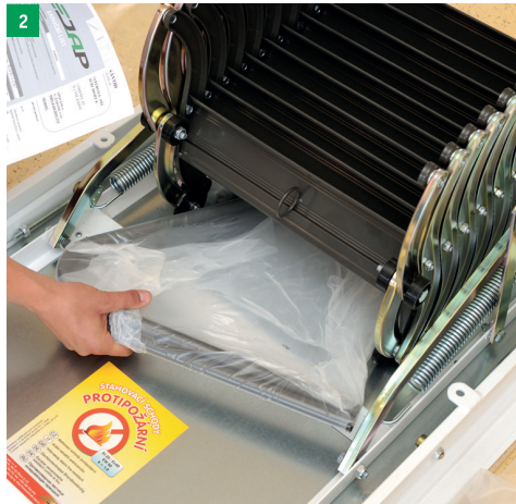
kontrola dodaného typu a rozměru stahovacích schodů
