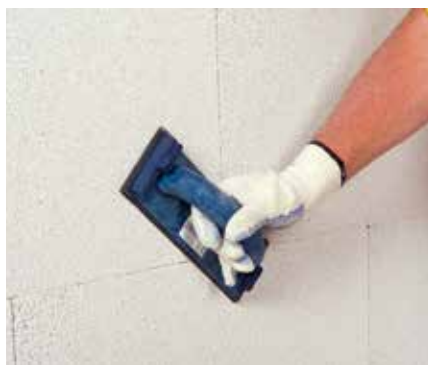
Vyrovnání povrchu provádíme, např. dřevěnou latí nebo brusným hladítkem.
