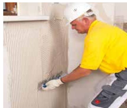
První vrstvu malty Multipor nanášíme ocelovým hladítkem (zub 10 mm) v min. tl. 6 mm.
