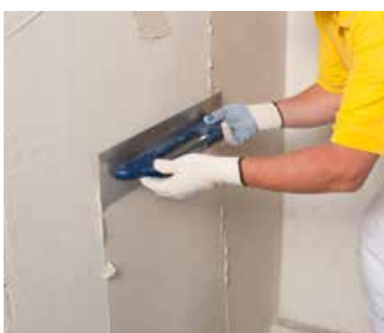
Po aplikaci výztužné tkaniny nanášíme krycí vrstvu.
