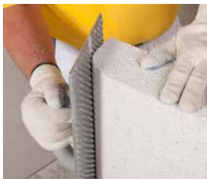
Tvarové úpravy, např. zaoblení hran, provádíme ocelovým brusným hladítkem.
