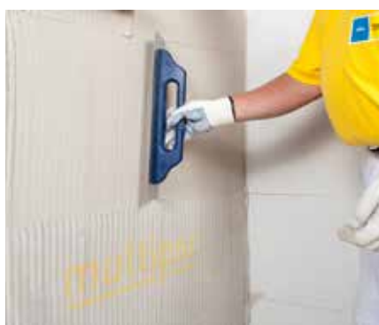
Do první vrstvy vkládáme výztužnou tkaninu s gramáží 160 g/m 2 .
