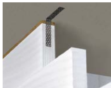
Ukotvení ke stropní konstrukci
