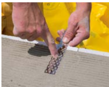
Průběžné vkládání spojky zdiva do ložné spáry
