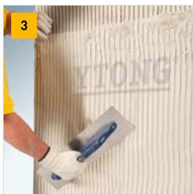
Vložení Ytong výztužné tkaniny
