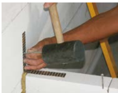
Dodatečná montáž spojky zdiva
