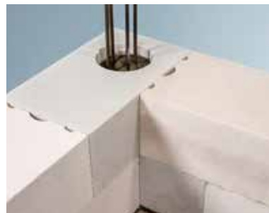
Vyzdění a vybetonované dvě řady
