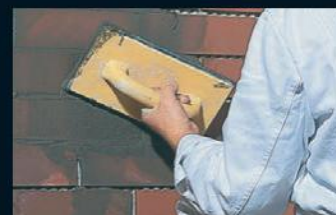
Celoplošné spárování
