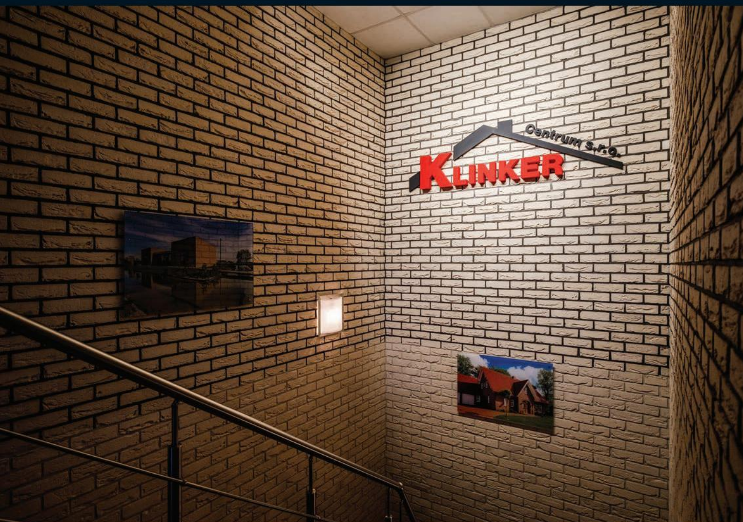
Vliv spárovací hmoty v ploše – cihlový obklad Como vyspárováný částicově antracitovou a bílou spárou
