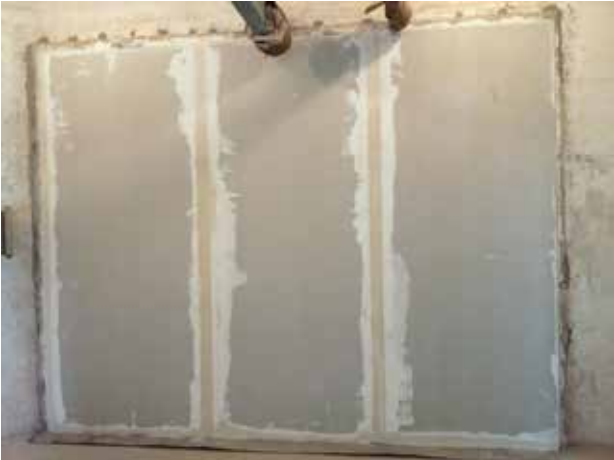
Provedený bodově lepený obklad sádrokartonovými deskami
