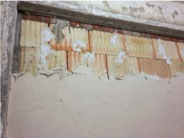
Provádění sádrové omítky
