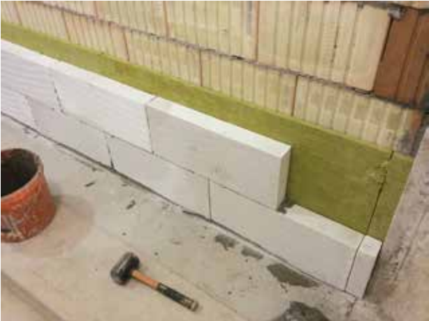
Provádění oddělené předstěny z pórobetonu na neomítnutou stranu mezibytové stěny
