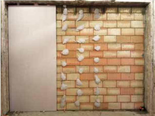
Provádění bodově lepeného obkladu sádrokartonovými deskami
