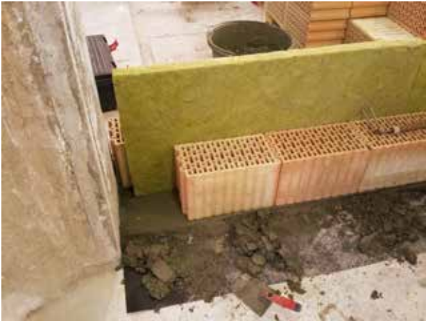
Provádění dvojité konstrukce z Porotherm 19 AKU Profi + MW Isover UNI
