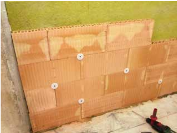
Provádění oddělené předstěny z Porotherm 8 Profi Dryfix na neomítnutou stranu mezibytové stěny
