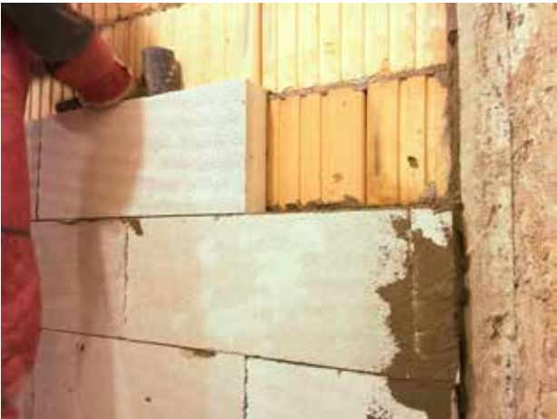
Provádění celoplošně přilepné přízdívky z pórobetonu na neomítnutou část mezibytové stěny
