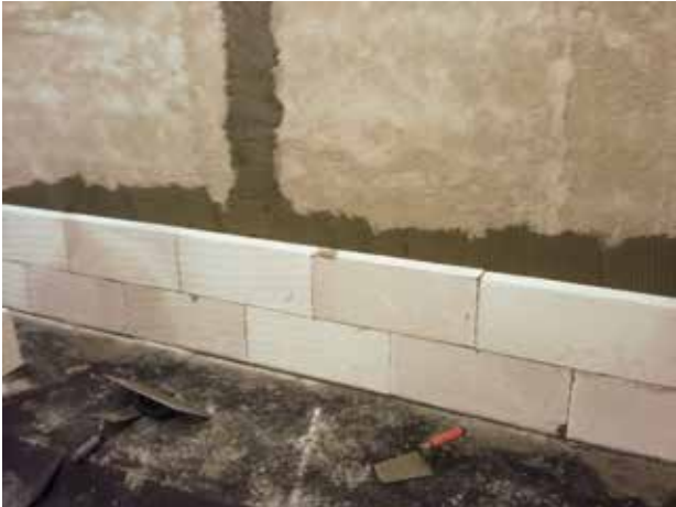
Provádění celoplošně přilepné přízdívky z pórobetonu na omítnutou mezibytovou stěnu
