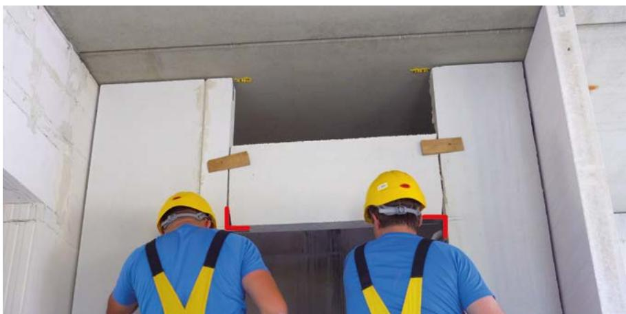
Na styčnou spáru panelu se nanese Ytong zednickou lžící Ytong malta fix P tak, aby po stlačení panelů měla hotová styčná spára tloušťku 2–3 mm. Přebytečná malta se odstraní po zavadnutí.
