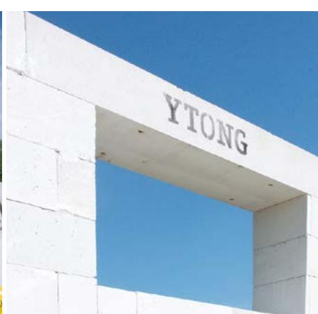
Správně zabudovaný překlad má ložné spáry stejné tloušťky jako zdivo. Minimální úložná délka překladu musí být od 175 do 250 mm podle typu překladu!
