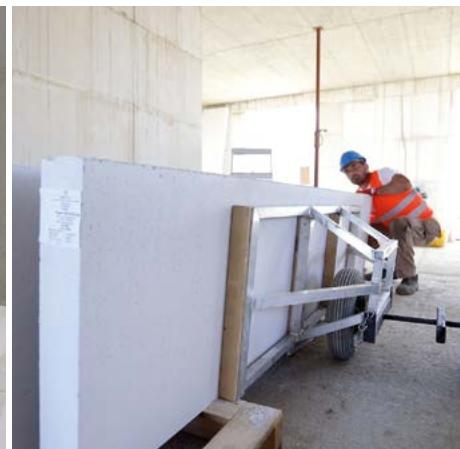
Rozmístění palet s Ytong příčkovými panely na jednotlivá podlaží se provede tak, aby rovnoměrně zatěžovaly strop, odpovídaly potřebnému množství pro montáž panelových příček v dané místnosti a zároveň nebránily provedení stropu nad daným podlažím. Rozmístění je zakresleno v montážním plánu.
