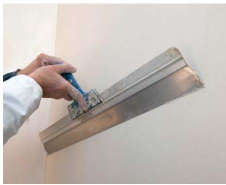
Stěrku nanášíme ručně na podklad z vápenocementových a vápenných omítek bez nutnosti penetrace v tloušťce 1–2 mm ocelovým kletovacím hladítkem a po stažení latí necháme zavadnout.
