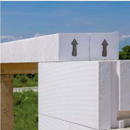
Ytong ploché překlady jsou trámce výšky 125 mm, na něž se provede na stavbě vždy nadezdívka min. výšky 125 mm, železobetonový věnec nebo železobetonová deska.
