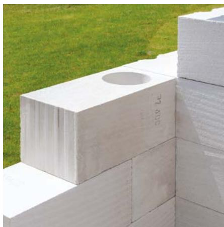
Následující vrstvy se zdí na Ytong zdíci maltu při dodržení vazby zdiva. Doporučujeme vždy maltovat svislé styčné plochy pilířových tvárnic, a to i v případě tvárnic PDK.
