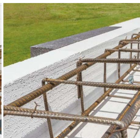
Do jádra U profilu vložíme předem připravenou výztuž – armokoš, fixujeme jeho polohu, abychom zajistili potřebné krytí výztuže betonem. Případnou dodatečnou tepelnou izolaci vložíme podle projektu.
