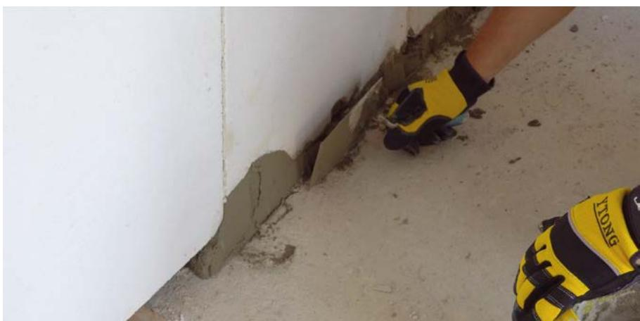
Po ustavení všech Ytong příčkových panelů se vyplní spáry mezi panely a nosnými stěnami, popř. stropem (vertikální i horizontální) montážní pěnou. V případě požadavku na požární odolnost konstrukce, použijte protipožární PUR pěnu.
