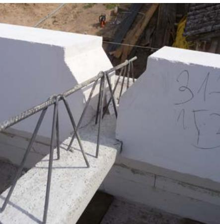
Rozestup nosníků zabezpečíme střídavým ukládáním vložek a nosníků. **Je bezpodmiňo-
