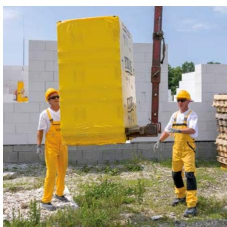
Paletu s tvárnicemi ukládáme na předem připravenou rovnou, zpevněnou a odvodněnou plochu.
