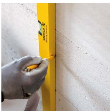
Polohu budoucí příčky si vyznačíme podle projektu pomocí vodováhy tužkou na nosné stěně, přičemž dbáme na svislost. Na stěně vyznačíme obě hrany příčky.
