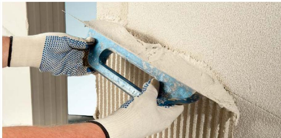
Omítku naneseme na stěnu ručně zubovou stěrkou se zubem o rozměrech 10×10 mm nebo strojově v tloušťce cca 5–6 mm a následně pročešeme zubovou stěrkou se zubem výšky 10×10 mm. Doporučujeme nanášet nebo pročesávat se sklonem stěrky 45°. Zubová stěrka dávkuje a rozprostírá omítku na plochu v potřebné tloušťce a množství.
