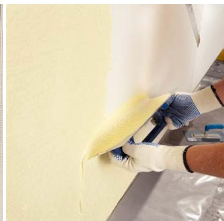
Po vyzrání cca 5–7 dnů (skutečná doba zrání se odvíjí od klimatických podmínek) je možné na takto upravený podklad nanášet finální vrstvu. Jako finální vrstvu je možné aplikovat běžné minerální, silikátové nebo silikonové fasádní strukturální omítky.
