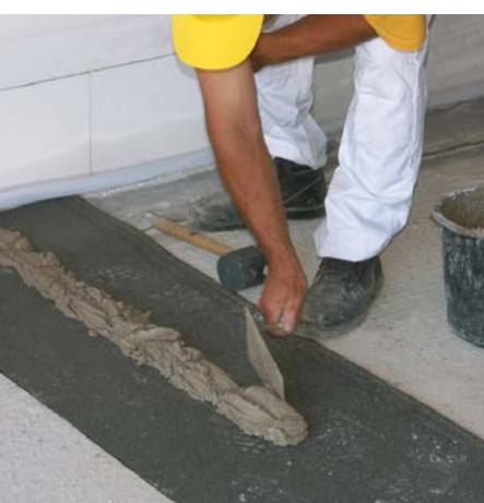
Pod příčku rozprostřeme separační folii, např. asfaltovou lepenku, toto platí i pro založení příčky v patře. Zakládáme na **Ytong tepelněizolační maltu nebo Silka/Ytong zakládací maltu** tloušťky min. 10 mm pod celou plochou tvárnice.
