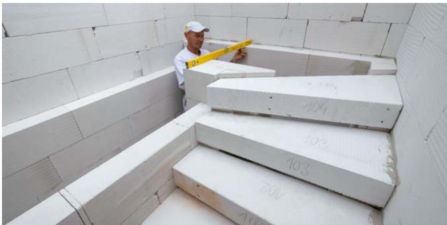
V případě ukládání stupňů k již hotovým stěnám musíme přizdít stěnu tloušťky 150 mm, čímž vznikne podpěra stupňů. Takové schodiště nazýváme „podezděné“. Tento způsob uložení využijeme hlavně při rekonstrukci nebo dodatečném vyhotovení schodiště.
