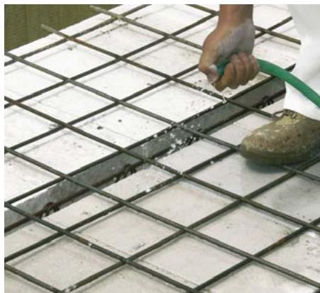
Polohu sítě v betonu zabezpečíme vhodnými podložkami. Po položení sítě strop důkladně navlhčíme vodou. Po stropě se dá chodit bez rizika propadnutí.
