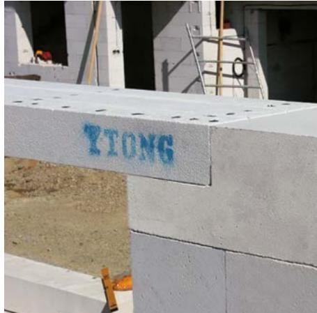
Pro dosažení správné výšky otvoru zapustíme ploché překlady do celé tvárnice.
