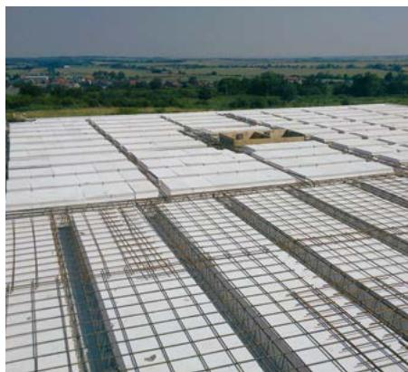
Systém stropů Ytong Klasik a Ytong Ekonom v tloušťce 250 mm se dá výhodně kombinovat. Záleží na rozpětí jednotlivých polí stropu a statickém návrhu.
