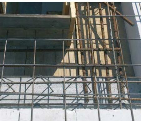
Na korunu zdi po obvodu stavby vyzdíme pomocí tenkovrstvé Ytong zdicí malty řadu věncových tvárnící, izolací vždy směrem dovnitř. Prostor pro věnec je ohraničený stropními vložkami a věncovými tvárnicemi.
