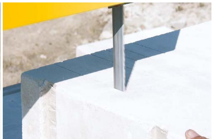
Ruční nebo elektrickou pásovou pilou vytvoříme kolmé zářezy ve vzdálenosti 40–60 mm od sebe.
