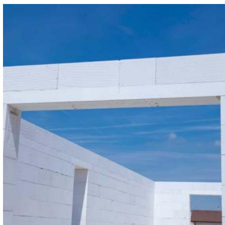
Po vytvoření překladu dozdíme zbytek zdi do stejné výšky. Překlad z plochých překladů je nosný až po 28 dnech, tj. po úplném vyzráni zdicí malty v konstrukci překladu. Montážní podepření můžeme odstranit až po úplném vyzráni konstrukce.
