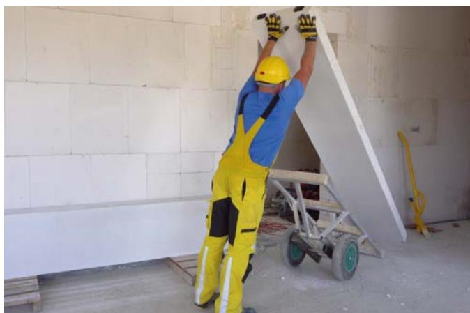
Pomocí manipulačního vozíku se bezpečně dopraví panel na místo budoucí příčky. Zde se obouručně panel vztýčí do svislé polohy.
