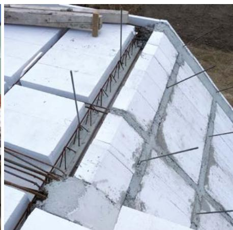
Do betonových žeber můžeme před betonáž osadit pomocné prvky – např. závitové tyče pro pozdější upevnění tepelné izolace a kontralatě. Po smontování všech prvků konstrukce přistoupíme k betonáži. Betonem zaléváme všechna prázdná místa [nosníky, přičná žebra, výměny] tak, abychom dosáhli hladké roviny střechy.
