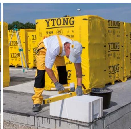
Po bezchybném vyhotovení hydroizolace vyměříme přesné rozměry půdorysu a polohu budoucích obvodových stěn podle projektu! Před začátkem zdění provedeme kontrolu rovinnosti základové desky nebo podkladné desky, která musí splňovat výškovou toleranci max.  $\pm 25$  mm.
