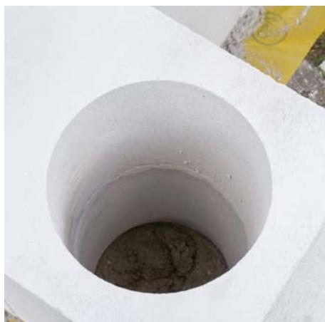
Zhotovení železobetonového pilíře skrytého ve zdivu je snadné. Postup zdění pilířových tvárnic je shodný s běžnými tvárniciemi. První pilířová tvárnice se založí do Ytong zakládací malty tepelněizolační, rovněž tak sousední „normální“ tvárnice.
