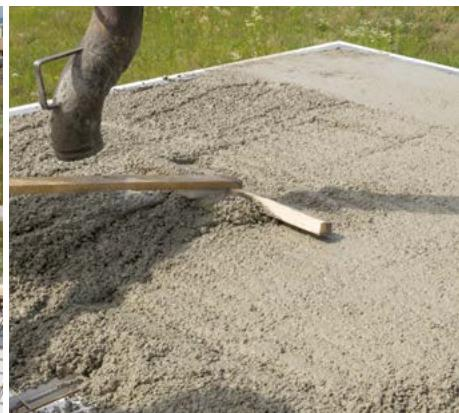
Beton rozprostíráme v co největší ploše. Snažíme se dodržet maximální rovnost a hladkosť povrchu.
