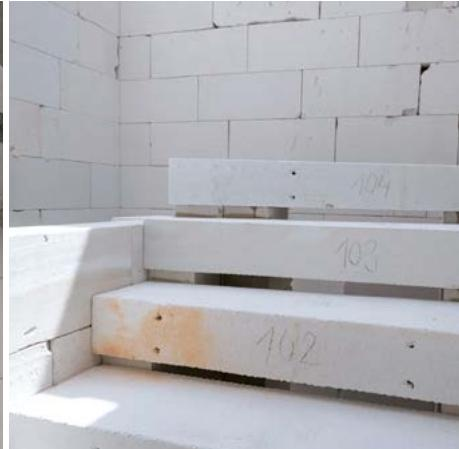
Po osazení všech stupňů pokračujeme ve zdění schodišťové stěny až po horní úroveň ostatních nosných stěn.
