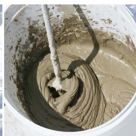
Rozmíchaná malta má mít takovou konzistenci, aby se drážky vyrobené Ytong zednickou lžící při nanesení malty na stěnu neslévaly a zároveň se nerolovaly za lžící.
