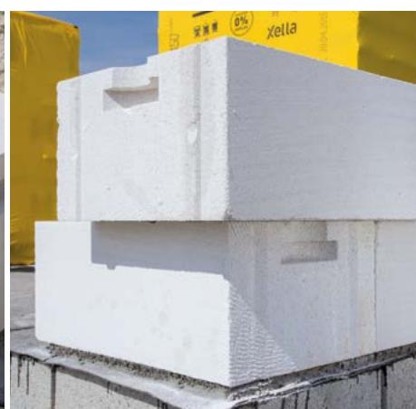
Zkontrolujeme výškové osazení tvárnic ve všech rozích. Ideální je použít nivelační přístroj nebo rotační laser.
