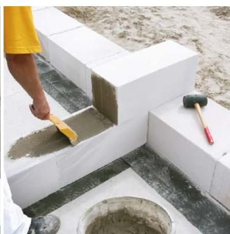
Při použití hladkých tvárnic (bez pera a drážky) musíme nanést Ytong zdicí maltu i na svislou stěnu tvárnice.
