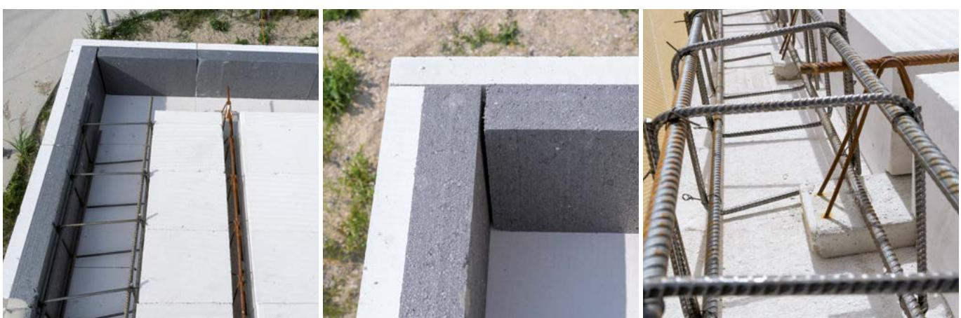
Mezera mezi stropní konstrukcí a věncovými tvárnicemi slouží k vytvoření věnce v úrovni stropu, který obíhá kolrem celé stavby.
