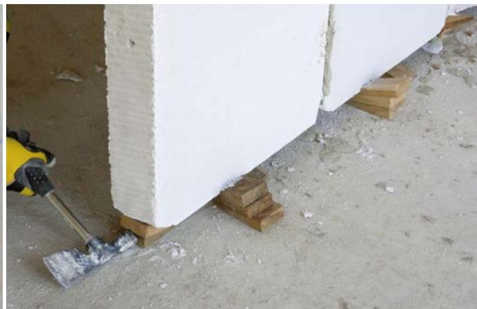
Pod panel se v podélném směru vkládá dřevěný klín, který později nebude odstraněn. Tím se panel zajistí proti posuvu. Zajištění panelu klínem se provádí počínaje druhým panelem a dále každý panel, který není fixován ke stropní konstrukci.
