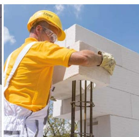
Po zabetonování nižších řad tvárnic musíme další řady pilířovek pokládat na výztuž shora. V případě potřeby je možné podélno výztuž napojovat přesahem podle předpisu statika.
