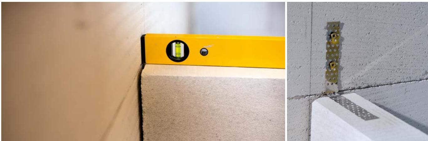
Mezi nosnou stěnou a příčkou necháme dilatační mezera min. 10 mm, do které vložíme pás minerální vlny, nebo ji po vyzdění příčky vyplníme nízkoexpanzní montážní pěnou.
