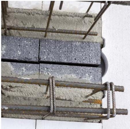
Do obou jader takto připraveného bednění vložíme předpřipravenou výztuž. Výztuž překladu přečnívá do stropní konstrukce, tak aby byl nosník dostatečné výšky a tím i únosnosti.
