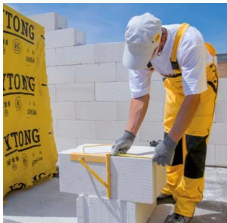
Nejprve si naměříme požadovaný rozměr a s pomocí uhelníku si na tvárnici předkreslíme svislé hrany, tak abychom zajistili kolmost řezané plochy.
