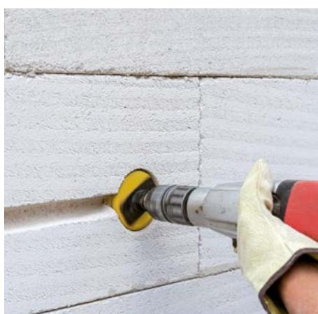
Otvory pro krabice vypínačů se jednoduše navrtají pomocí speciálního vrtáku a vrtačku bez příklepu.
