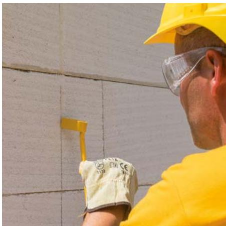
Vytváření drážek pomocí drážkovače představuje jednoduchý úkon.
