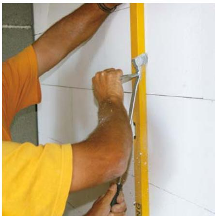
Drážkovač taháme podle pevného pravítka, čímž dosáhneme rovné drážky v požadovaném směru.
