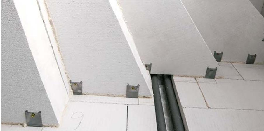
Schodišťové stupně můžeme uložit i na speciální Ytong schodišťové konzoly zhotovené z nerez plechu. Toto řešení je výhodné při rekonstrukcích nebo dodatečném osazení schodišť v rodinných domech, které mají nosné zdvoje z pórabetónových tvárníc, přičemž světlá šířka schodiště může být maximálně 1 200 mm. Polohu stupňů si můžeme vykreslit na již existující zeď. Další výhodou je, že si zvětšíme užitkový prostor pod schodištěm.
