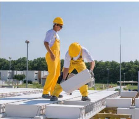
Po rozložení nosníků podle dodaného výkresu skladby je třeba vystavět podpěrnou konstrukci v rastru  $1,6 \times 1,6$  m. Předepsané nadvýšení středů nosníků se provede korekcí výšky sloupků podpěrné konstrukce. **Před zhotovením montážního podepření je zakázáno jakkoliv nosníky zatěžovat!**
