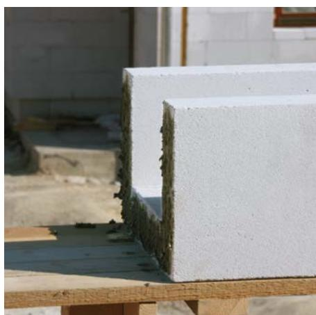
U profily klademe na sraz a lepíme v čele mezi sebou. Používáme tenkovrstvou Ytong zdící maltu. Dbáme na rovinnost a přesnost uložení U profilů.
