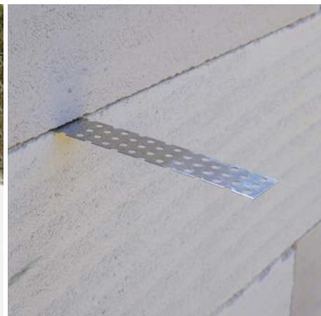
V místě budoucí příčky je možné osadit do ložné spáry nosného zdíva Ytong spojku zdíva. Spojku vmáčkneme do nanesené malty tak, aby polovina vyčnívala ven ze zdíva.
