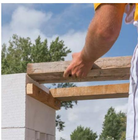
Pod překladem z U profilů a YQ U profilů nejdříve zhotovíme bednění.
