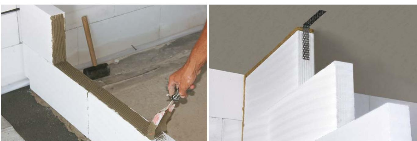
Ytong zdicí maltu nanášíme celoplošně i na svislé plochy tvárnic.
