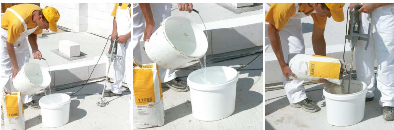
Na přípravu malty potřebujeme jednoduché pomůcky, Ytong míchadlo zapojené do elektrické vrátky, nádobu na rozmíchání malty a vodu.
