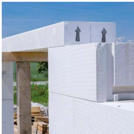
Případné nerovnosti a nepřesnosti při položení upravíme poklepem gumovou paličkou.
