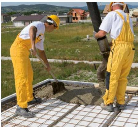
Nejvhodnější a nejrychlejší je betonáž pomocí pumpy z domíchávace. Použitý beton musí mít předepsanou kvalitu statikem podle ČSN EN 206-1, minimálně však třídu C20/25.
