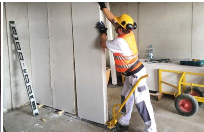
Ustavení Ytong příčkových panelů se provede pozvednutím ručním páčidlem, tak aby stlačení gumových podložek činilo cca 3 mm. Aby bylo možné páčidlo dostat hlouběji pod panel, seřízne se jeho spodní čelní roh. Panely se srovnávají do linie vyznačené na stropě, současně se kontroluje svislost 2m vodováhou. Ustavený panel se z obou stran vyklínuje dřevěnými klíny.
