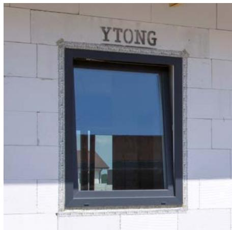
Nejjednodušší překlenutí otvoru vytvoříme pomocí Ytong nosných překladů příslušné délky a šířky, čímž nám vznikne nadpraží s min. výškou 250 mm.
