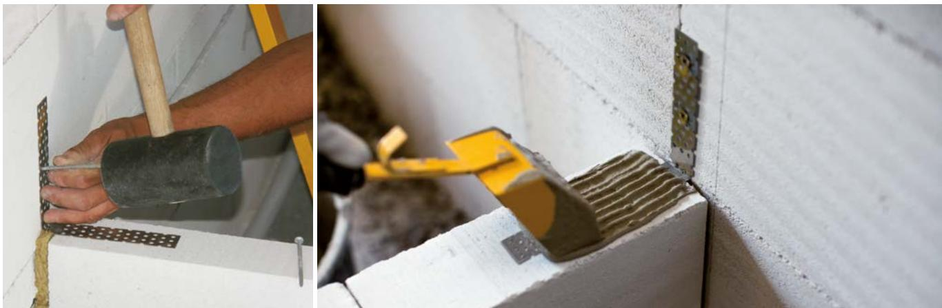
Pro přichycení použijeme hmoždinku a šroub nebo hřebíky s protikorozní úpravou.
