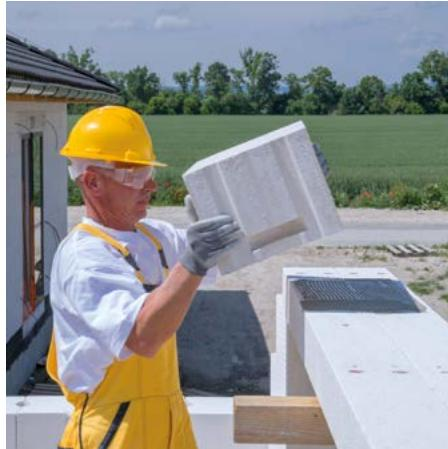
Tvárnice s pevností min.  $f_b \geq 2,7 \text{ N/mm}^2$  klademe na ploché překlady do Ytong zdicí malty M5, nebo do Ytong/Silka zdicí malty zimní M10 a dbáme na to, aby malta byla nanesena na celou plochu zdíva.
