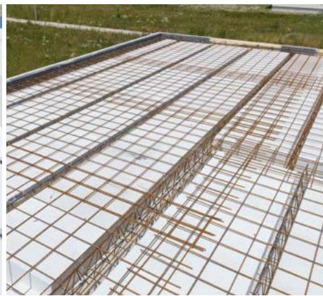
Před betonáží horní části desky umístíme celoplošně výztužnou síť do betonu, min. profilu  $\varnothing 5/150 \times \varnothing 5/150$  mm. Do mezery mezi stropní vložky a věncové tvárnice vložíme výztuž věnce.
