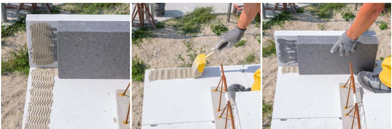
Věncovou tvárnici lepíme Ytong zdící maltou na celé úložné ploše, stejně tak na čele.
