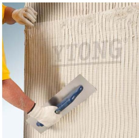
Do srovnáné vrstvy vtlačíme Ytong výztužnou tkaninu. Výztužná tkanina musí být uložena přibližně v 1/3 tloušťky omítky od vnějšího povrchu. Překrytí styků musí být minimálně 10 cm.
