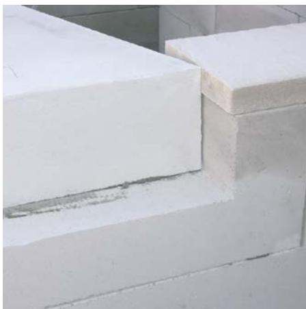
Schodišťová nosná stěna je zpravidla široká 250 mm, stupeň v ní je uložen minimálně 150 mm. Zbylý odskok 100 mm později využijeme pro vazbu při dozdění této stěny na plnou výšku. Stupně ukládáme do Ytong zdící malty.
