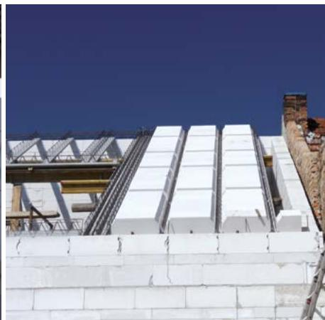
Zhotovíme montážní podepření, dbáme na důkladnou fixaci montážních podpěr, aby nedošlo k jejich uvolnění.
