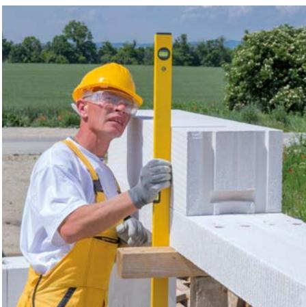
Přesnosti sesazení tvárnic dosáhneme pokleppem gumovou paličkou, a poté vodováhou kontrolujeme usazení tvárnic vodorovně i svisle.
