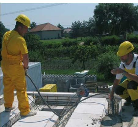
Před betonáží stropu se provede kontrola podle kladečského plánu, jednak uložení betonářské oceli a také předepsané nadvýšení. Strop důkladně navlhčíme vodou. Po stropě se dá chodit bez rizika propadnutí.
