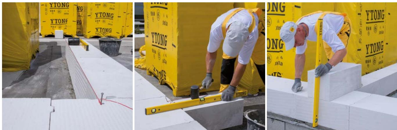
Nosnou vnitřní stěnu spojíme s obvodovou stěnou nepevně – vazbou zdíva. První řadu tvárnic klademe na Ytong zakládací maltu tepelněizolační nebo Silka/Ytong zakládací maltu. Ideálně pomocí řádně napnuté zednické šňůry.
