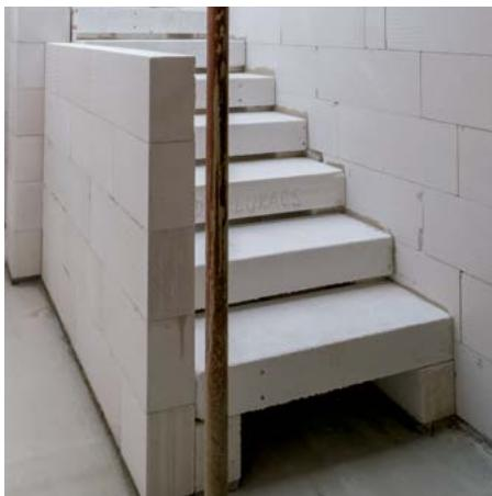
Dílec schodišťového stupně je vysoký 150 mm. Výška a šířka stupňů schodiště se řeší výškou osazení a přesahem jednotlivých dílců nad sebou podle výkresu skladby. Případné mezyry vyplníme podle jejich velikosti buď odrezky z pórabetonu nebo jen maltou.
