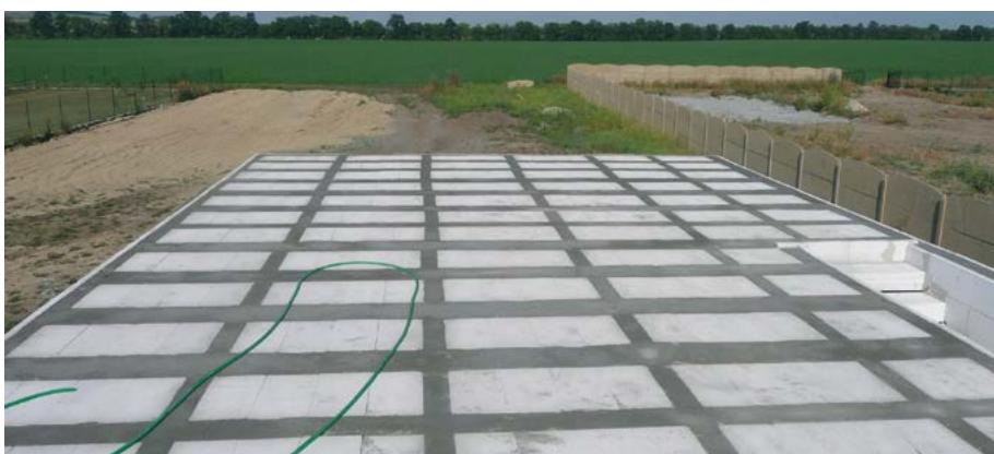
Po zabetonování je konstrukce druhý den pochozí. Je však nutné dbát na to, aby nedošlo k přetížení montážních podpěr pod stropem. V průběhu prvního týdne až prvních 10 dní je nutné beton vlhčit. Podpěrnou konstrukci odstraníme nejdříve po 28 dnech, kdy beton dosáhne zaručené pevnosti a konstrukce je nosná.
