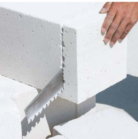
Nejběžnější na malých stavbách je řezání tvárnic pomocí ruční pily s vidiovými zuby.
