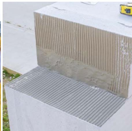
V místě uložení překladu naneseme Ytong zdící maltu Ytong zednickou lžící, a to i na svislou styčnou plochu.
