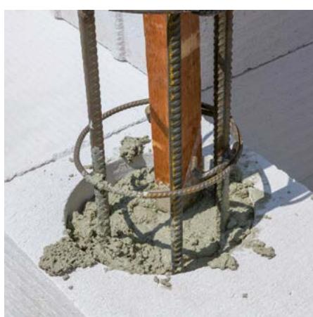
Betonujeme a hutníme postupně se zděním, nejlépe vždy po položení tří vrstev zdíva. Při takovém postupu lze korigovat polohu vložené výztuže i bez nutnosti její fixace v průřezu distančními prvky.
