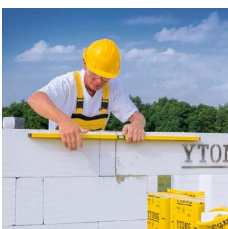
Zkontrolujeme správnost uložení i ve svislém směru. Případné nerovnosti je třeba upravit poklepkem gumovou palíčkou.
