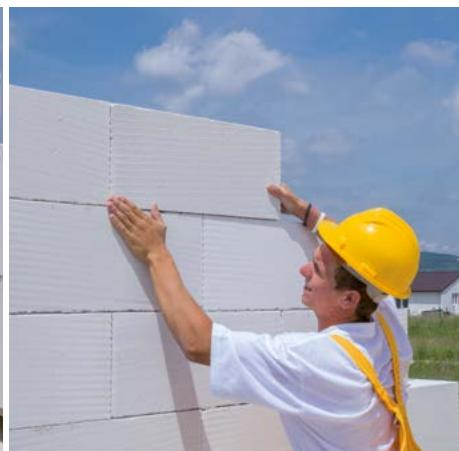
V případě budoucích otvorů můžeme jednoduše zaříznout tvárnici na požadovanou délku a tak vytvořit hladké ostění bez drážek a kapes.
