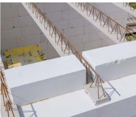
V době dodávky musí být na stavbě k dispozici technická specifikace stropu, podle níž před vykládkou zkонтrolujeme dodané zboží. Optimální je zajistit vyložení stropních nosníků přímo z vozidla na korunu zdi.
