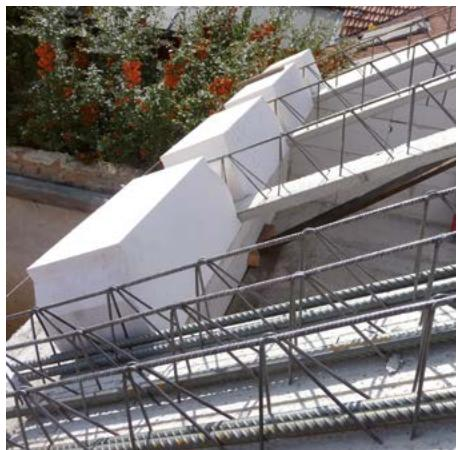
Alternativní možností je zakládání železobetonových nosníků rovnoběžně se spádem střechy. Nosníky začínáme klást podle projektu, vždy od plánovaného otvoru ve střeše nebo prostupu pro komín.
