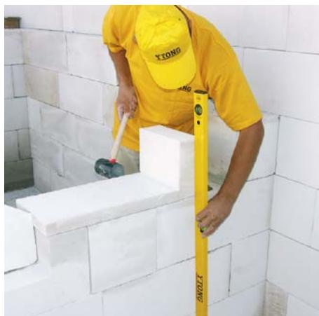
Pokud jsou schodišťové stupně vsazeny do nosných stěn, postupujeme tak, že nosné stěny zdíme současně se stupni. Pravidelně kontrolujeme půdorysný rozměr, kolmost a rovnost schodišťových stěn. Osazení tvárníc korigujeme poklepem gumovou palíčkou.
