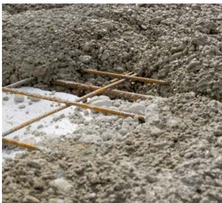
Je nutné betonovat v jednom sledu. O přerušení betonáže může rozhodnout stavební dozor, musí však rozhodnout také o způsobu ukončení práce. Při betonování stropu Klasik je třeba zajistit, aby krytý výztužné sítě v nadbetonávce bylo minimálně 15 mm.
