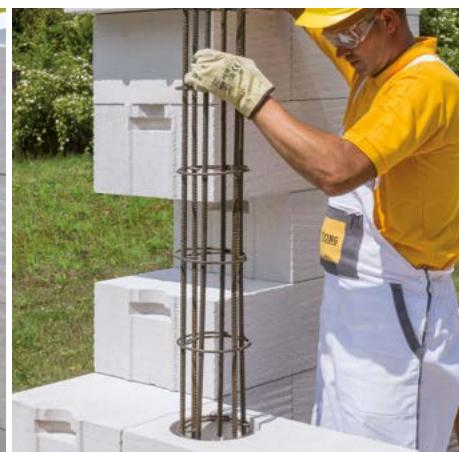
Do otvoru tvárnic vložíme předpřipravený armokoš s výztuží navrhnutou statikem.
