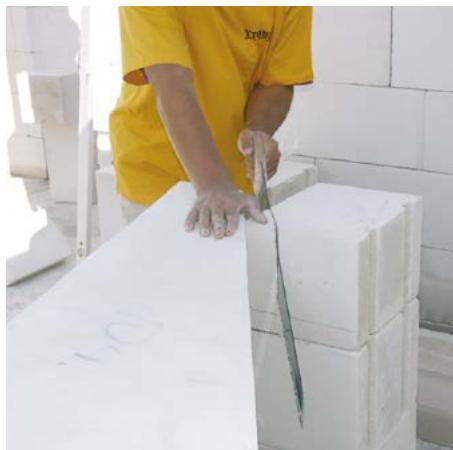
Při zdění nosné schodišťové stěny doporučujeme tvárnici pod stupněm před seřízením nejprve nasucho uložit a vyměřit její konečné rozměry.
