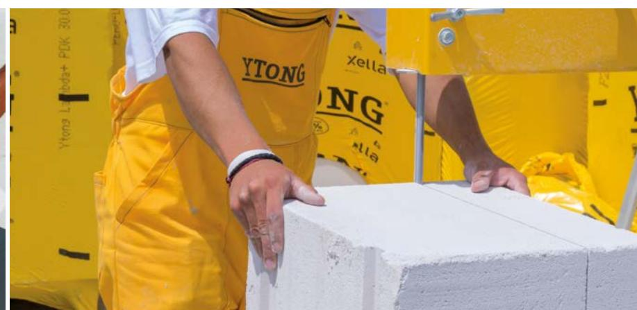
Na větších stavbách používáme elektrickou pásovou pilu. Tvárnice leží na posuvném stole pily, takže řezání je rychlé, jednoduché a bezpečné.
