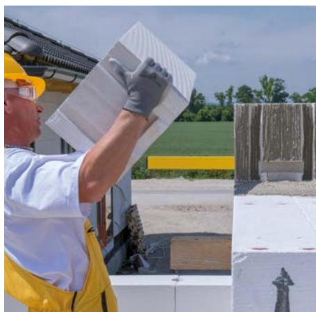
Ploché překlady nadezdíme jednou řadou tvárnic o výšce min. 125 mm. V místě překladu je nutno nanést zdicí maltu na svíslou styčnou plochu tvárnic i při použití tvárnic pero drážka.
