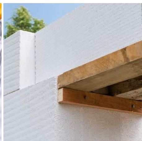
U profily a YQ U profily klademe na stěnu a bednění tak, aby úložná délka překladu byla min. 250 mm.
