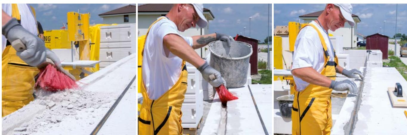
Drážku délky rovnající se šířce otvoru plus 0,5 m na každou stranu řádně očistíme.
