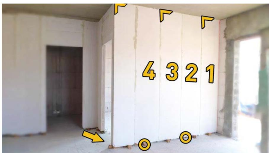
První pozinkovaná kotva se osadí na první montovaný panel. Kotva se upevní ke stropní konstrukci nastřelovacími hřebíky nebo natloukacími hmoždinky. Pokud montážní plán neurčí jinak, ke stropní konstrukci se ukotví každý první a poslední panel, v poli pak každý druhý panel a při otvorech každý panel. Při utěšňování spár minerální vatou se pružnou kotvou fixuje ke stropu každý panel.
