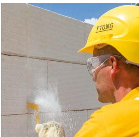
Vícenásobným tažením drážkovače vytvoříme drážku požadované šířky a hloubky.
