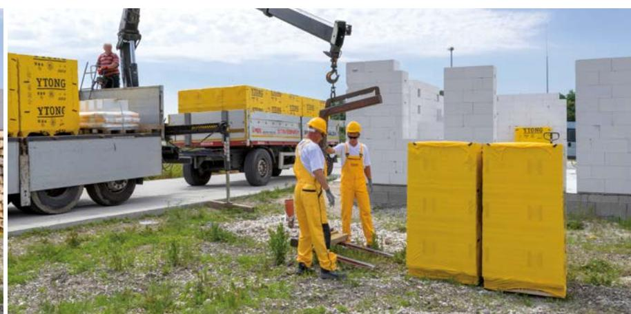
V případě skladování tvárnic na stavbě je zakázáno ukládat palety s tvárnicemi na sebe (stohovat do bloků nebo pyramid), pouze vedle sebe v jedné vrstvě!
