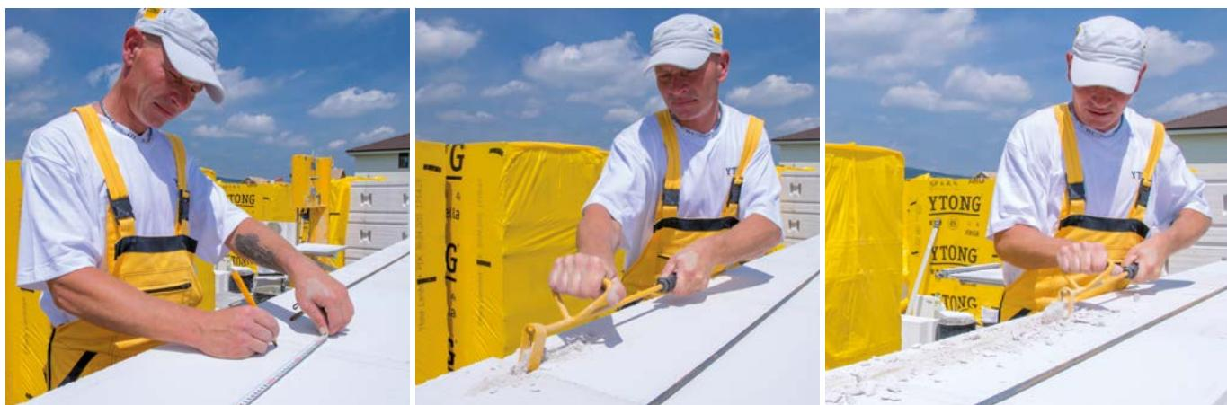
V předposlední řadě tvárnící u otvorů širších než 1,50 m doporučujeme pod parapetem umístit výztuž do předem připravené drážky. Délku drážky nejdříve vyměříme tak, aby výztuž přesahovala min. 0,5 m za budoucí ostění.
