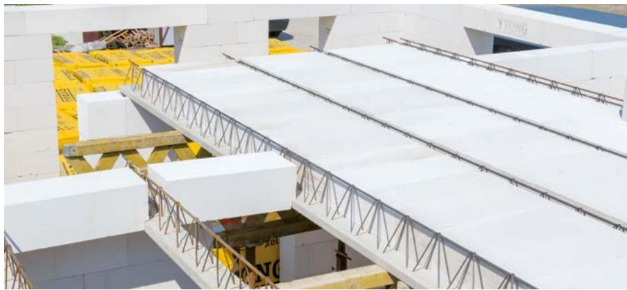
Montáž stropu probíhá obvyklým způsobem na předem rozmístěně a montážně podepřené nosníky.
