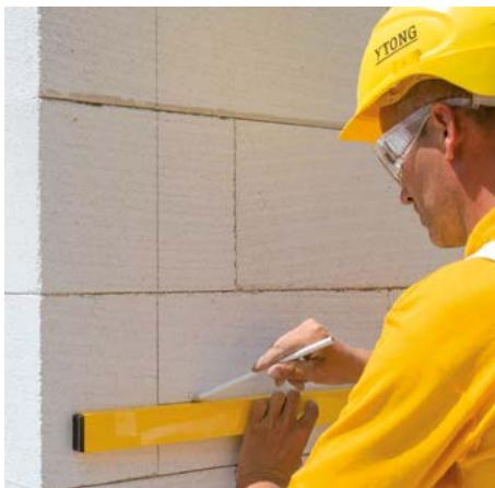
Před samotným drážkováním si na stěnu vyznačíme budoucí polohu drážek a instalačních krabic.
