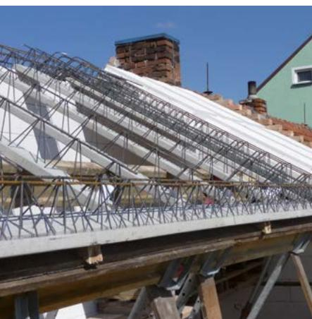
Vytvoříme ostatní pomocné konstrukce – výmény, skryté nosníky apod. Následně můžeme začít ukládat vložky po celé ploše střechy.
