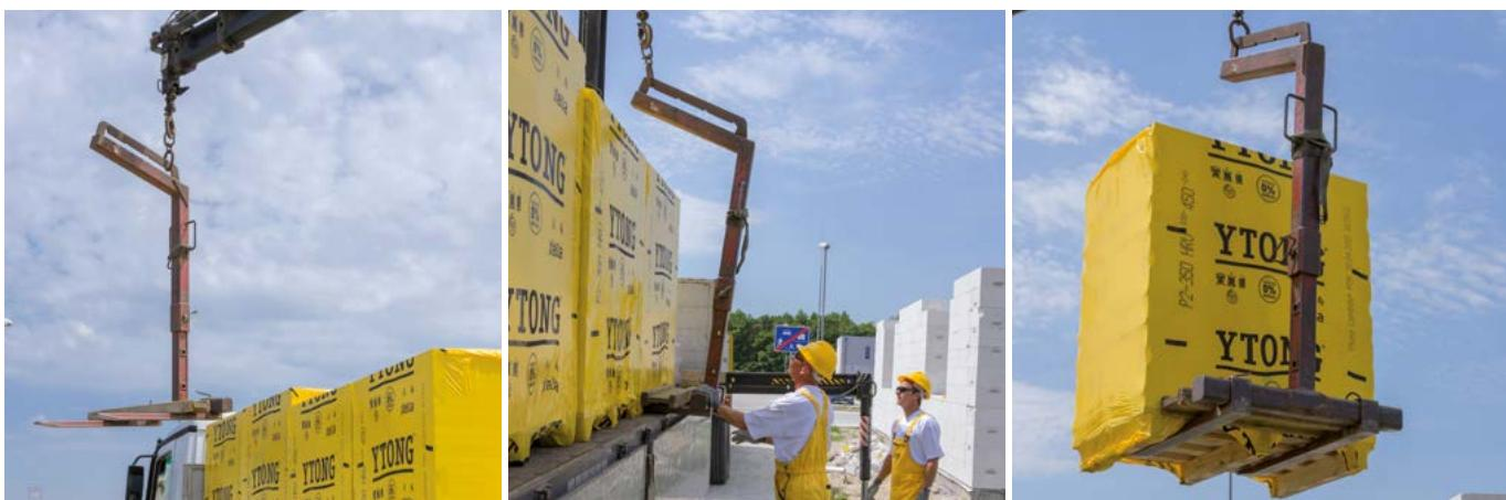
S paletami je zakázáno manipulovat závěsnými lany. Používá se speciální vykládací vidlice, tzv. „C“ závěs.
