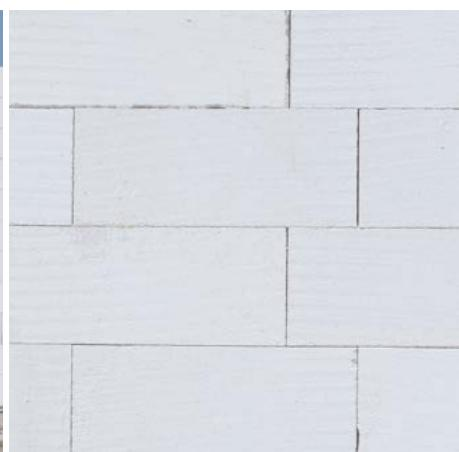
Maltu, která vyteče ze spáry, nikdy nerozmažáváme po ploše zdíva. Po zavádnutí ji seškrábeme ostrou hranou lžice, nebo po vytvrzení ji jednoduše odstraníme zbrošením, příp. oklepáním.
