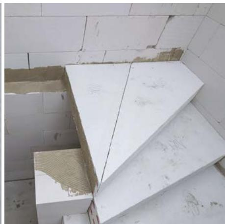
Při osazování například rohových stupňů můžeme využít kombinaci uložení stupňů, který je uložený do schodišťové stěny a na podezdívku u nosné obvodové stěny.
