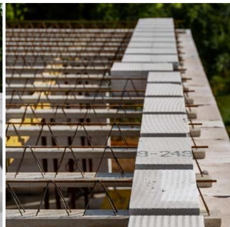
Sestavení střechy Ytong Komfort je stejné jako strop Ytong Ekonom. Střešní systém se skládá z prefabrikovaných železobetonových nosníků a stropních vložek Ytong 250/500 tloušťky 250 mm. Mezi každou čtvrtou vložku se vkládá snížená vložka výšky 100 mm.
