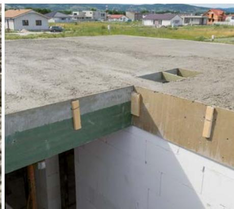
Během prvního týdne až 10 dní je nutné beton vlhčit. Podpěrnou konstrukci odstraníme nejdříve po 28 dnech, kdy beton dosáhne zaručenou pevnost a konstrukce je nosná. Není povoleno betonovat při teplotách nižších než 5 °C.
