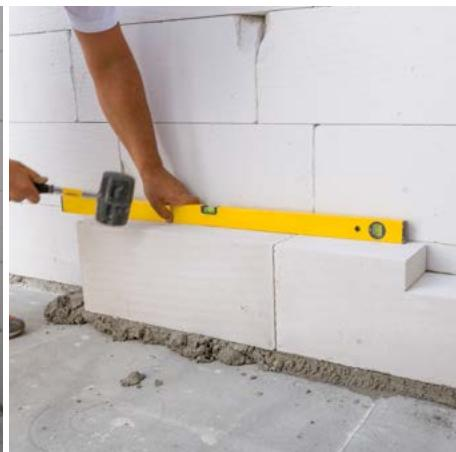
Nosné stěny a podezdívku schodů zdíme vždy na celoplošně nebo v pásech nalepenou hydroizolaci. (Na obrázku je podezdívka schodů.)
