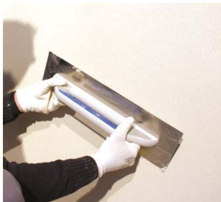
Při aplikaci omítky je vždy nutné dodržet technologický postup. Je nutné použít pitnou vodu nebo vodu odpovídající ČSN EN 1008.
