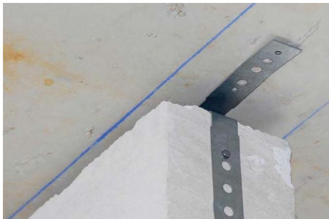
Vždy první a následně každý druhý Ytong příčkový panel se připevňuje do stropní konstrukce pomocí pružných pozinkovaných kotev.
