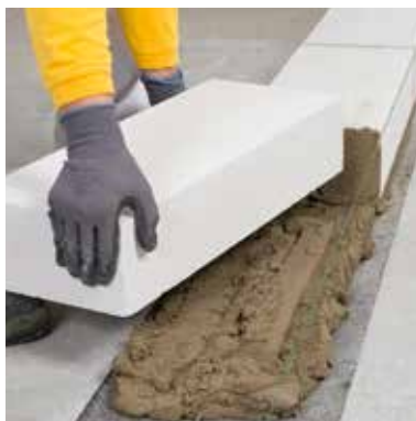
Zakládací tvárnice se pokládá do čerstvě nanesené základací malty.
