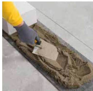
Minimální vrstva základací malty má být cca 20 mm (10–40 mm) pod celou plochou tvárnice.
