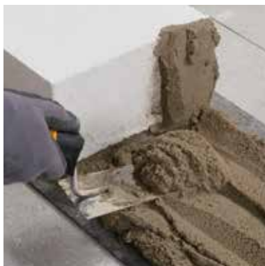
Ložné i styčné spáry musí být promaltovány v celé ploše.
