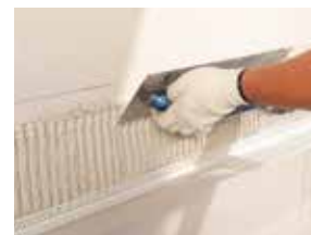
Pro založení nad soklem vždy volíme zakládací lišty pro externí zateplení
