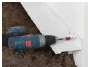
Pro založení nad soklem vždy volíme zakládací lišty pro externí zateplení
