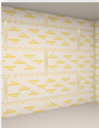
7. Tmelení svislých spár druhé vrstvy
