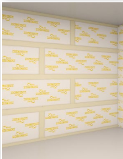
5. Tmelení vodorovných spár
