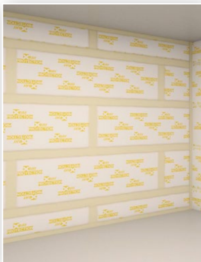
8. Tmelení vodorovných spár druhé vrstvy
