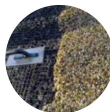
Hotový povrch TopStone
