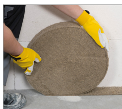
Založení první řady desek se vždy provádí na separační vrstvu
