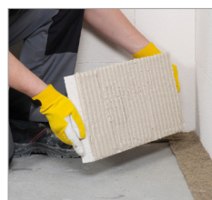
Založení první řady desek se vždy provádí na separační vrstvu
