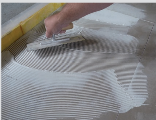
Nanesení lepidla Knauf Fugenfüller
