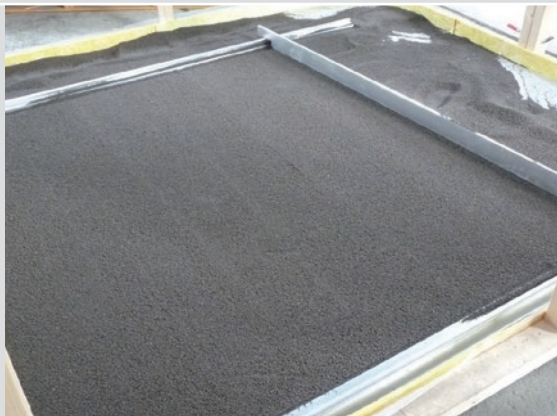
Vyrovnání podkladu suchým podsypem
