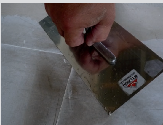
Tmelení spár tmelem Knauf Uniflott
