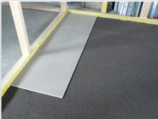
Založení první vrstvy desek
