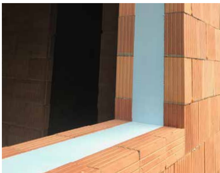
Parapet s ostěním a izolantem
