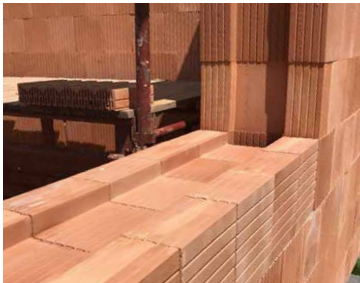
Parapet s ostěním
