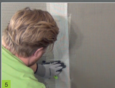
5 Fixace armovací pásky BOTAMENT® GS 12
