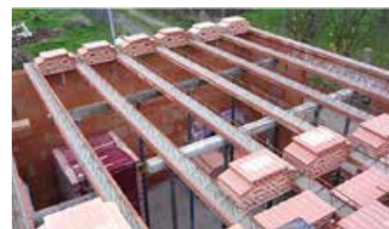
Obr. 3 Kladení vložek na předem podepřené trámy
