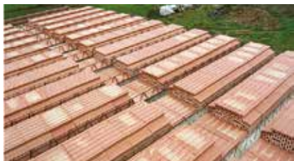
Obr. 4 Ztužující žebro z vložek výšky 80 mm před vložením výztuže
