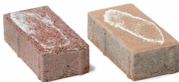
Dlažba s výkvětem
