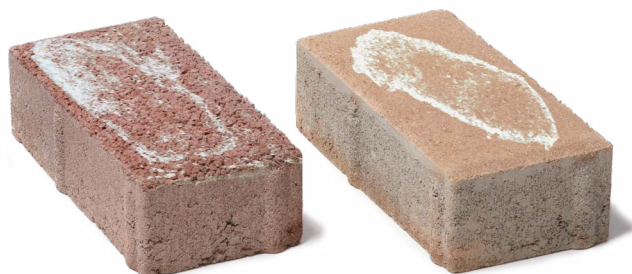
Dlažba s výkvětem
