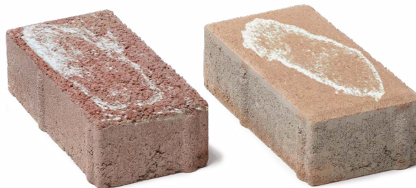
Dlažba s výkvětem
